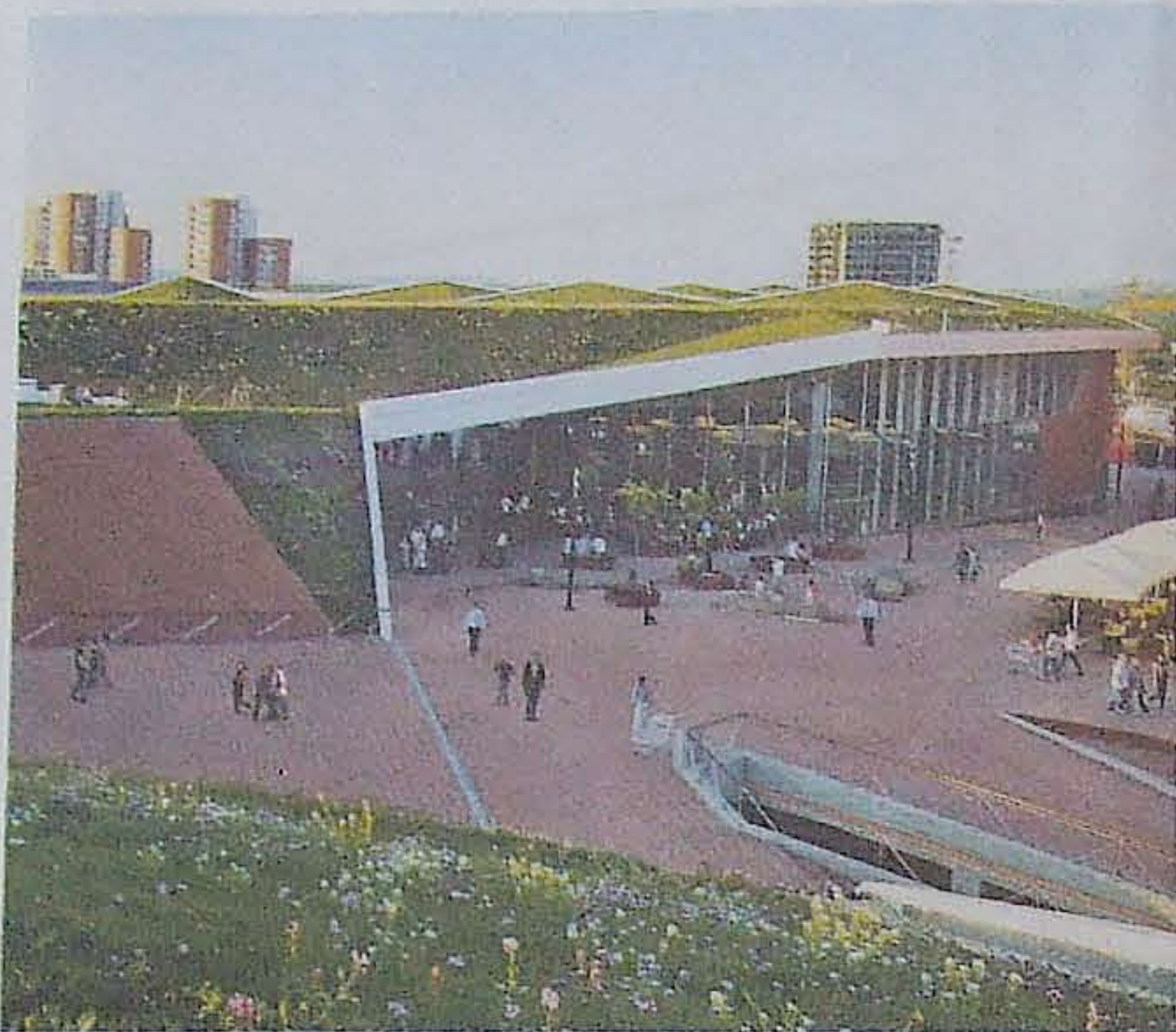
Moderner Marktplatz unter grüner Decke: Das Shopping Square „Meydan“ wird zu einem Großteil mit Erdwärme klimatisiert.
